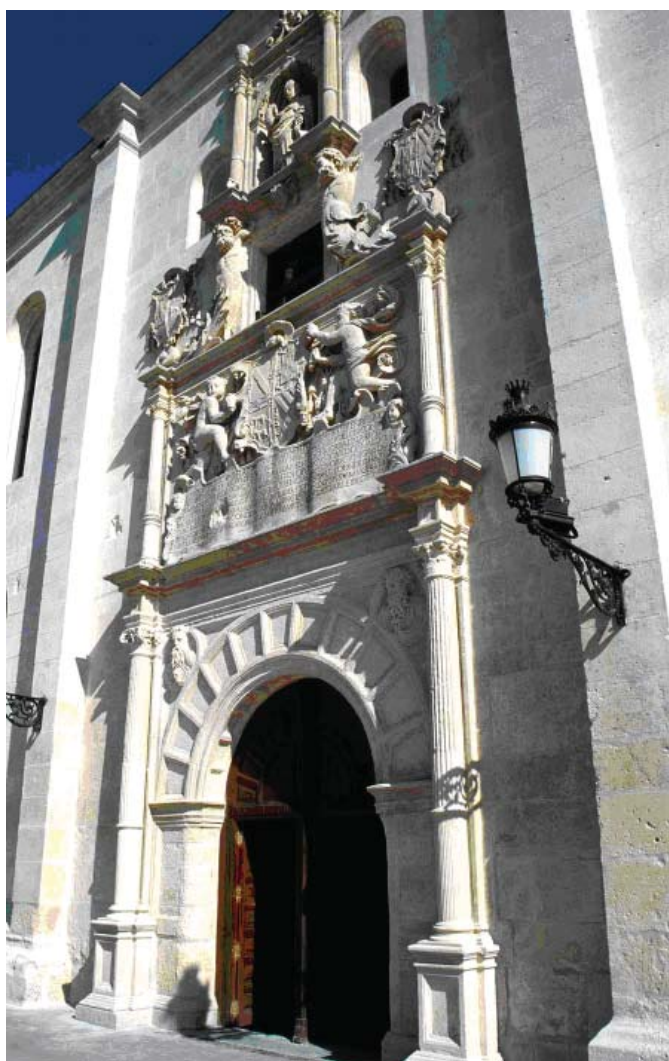
Foto 1. El edificio es una construcción renacentista de las más importantes de la ciudad de Burgos con una portada de gran belleza formal en desarrollo vertical.
