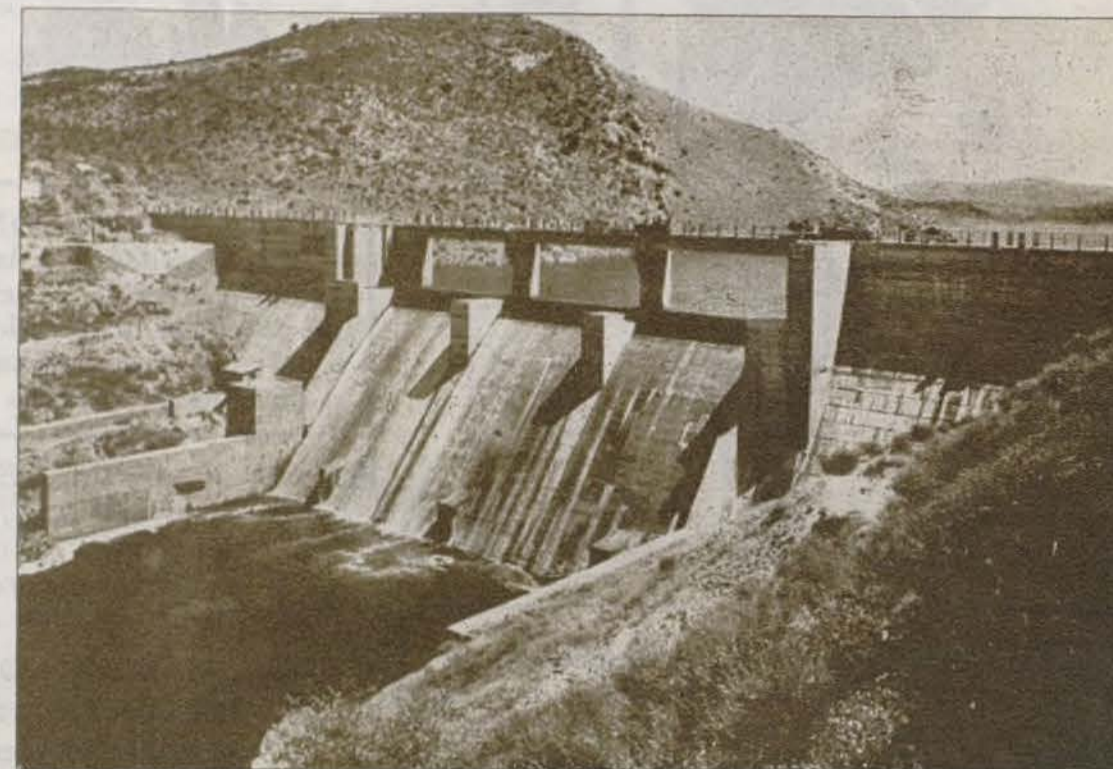
Presa de Valengo, construida por el Instituto Nacional de Colonización, en Jerez de los Caballeros, Badajoz.
