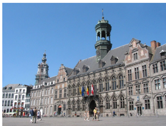
Fachada del Ayuntamiento de Mol
