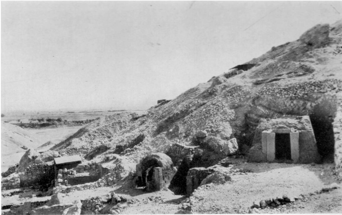
1. — La chapelle n° 8 avant sa restauration.
