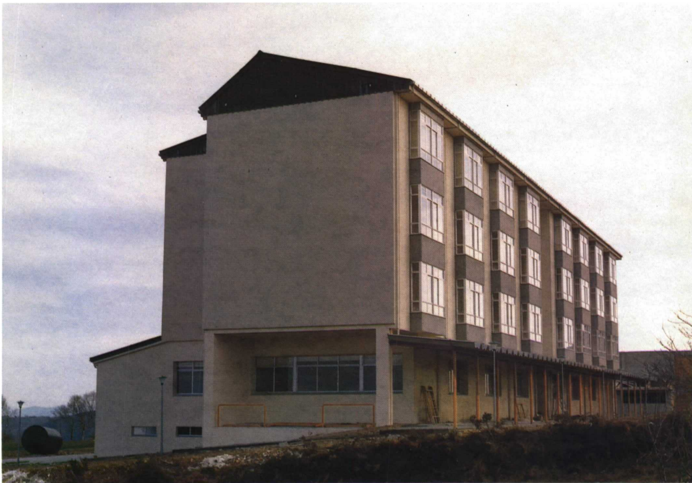
FONSAGRADA (LUGO). Escuela-Hogar. 300 puestos. (En funcionamiento 1979).
