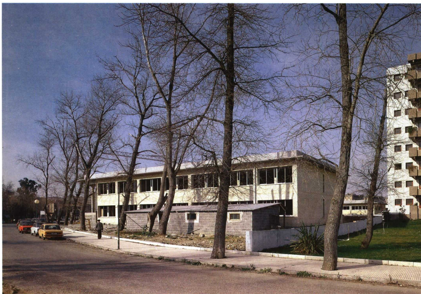
GUECHO (VIZCAYA), F.P. 840 puestos. (En funcionamiento 1979).
