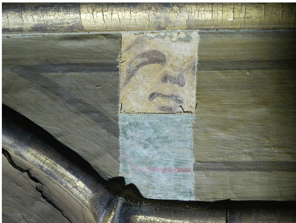
Figura 15. Detalle de una de las catas realizadas en la sala 07, donde se aprecia la sucesión de estratos decorativos, el último de los cuales es una capa de pintura de naturaleza alquídica bajo la que se encuentra otra, de similares características, aplicada sobre un soporte de tejido de algodón. Bajo este se documenta la existencia de papel pintado figurativo. Fotografía: Elsa M. a Soria Hernanz y Rosa Plaza Santiago.
