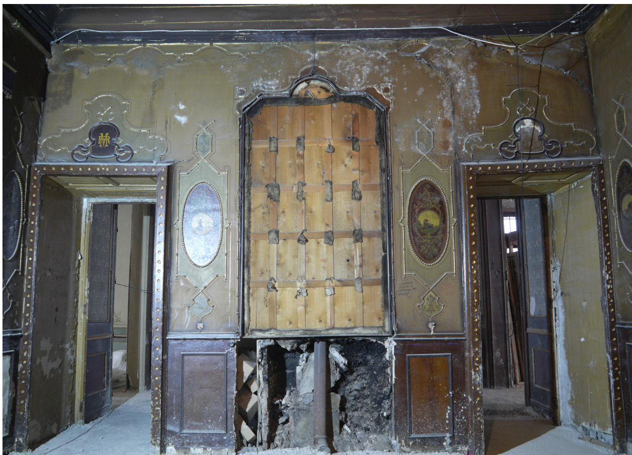
Figura 13. Aspecto de la sala 07 al comenzar los trabajos de rehabilitación del edificio. Fotografía: Elsa Soria Hernanz y Rosa Plaza Santiago.
