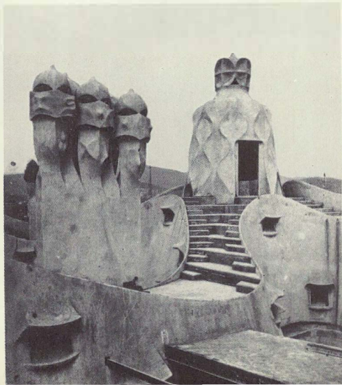
«Azotea de la Casa de Milá».
