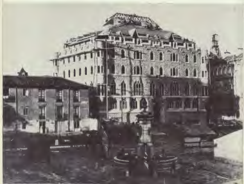
«Casa de los Botines en obras» (León 1892-1894).
