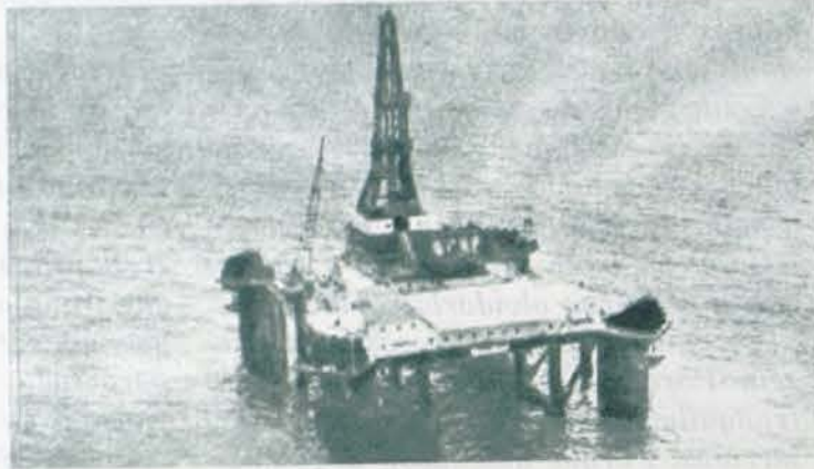
He aquí la plataforma instalada en el mar para los sondeos petrolíferos. Al fondo, la torre de perforación, que mide 60 metros de altura.
