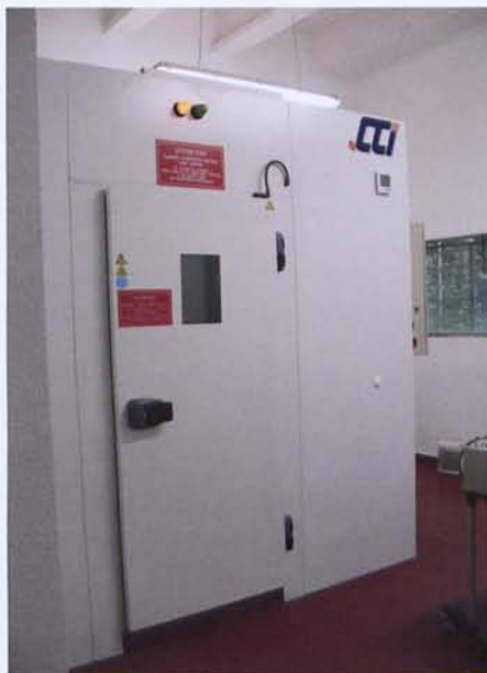
Figura 21. Cámara de desinsectación por anoxia del Museo del Traje. CIPE. Figure 21. Anoxic insect extermination chamber of the Museo del Traje. CIPE.
