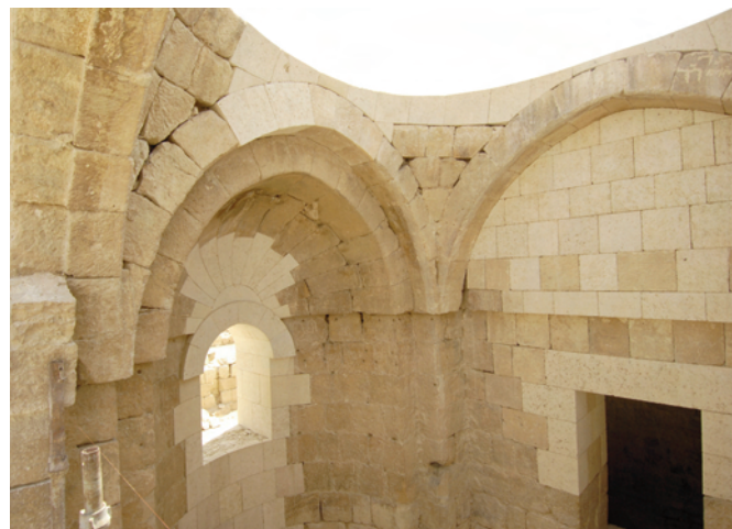
Fig. 1C Hammam as-Sarrah. Vista de las pechinas del caldarium después de la restauración, llevada a cabo por la Misión Española bajo la dirección científica y técnica del Autor y con financiación de AECID.
