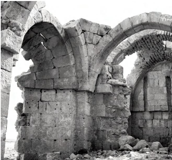
Fig. 1B Hammam as-Sarrah. Vista de las pechinas del caldarium antes de la restauración. Al fondo se aprecia la bóveda de aristas del tepidarium. (Foto cortesía del Departamento de Antigüedades jordano).
