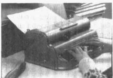
Máquina Perkins para escritura del Braille.
