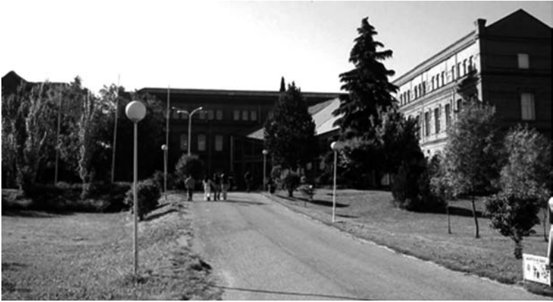
FIGURA 6.2. Imagen del acceso al IES Puerta Bonita
