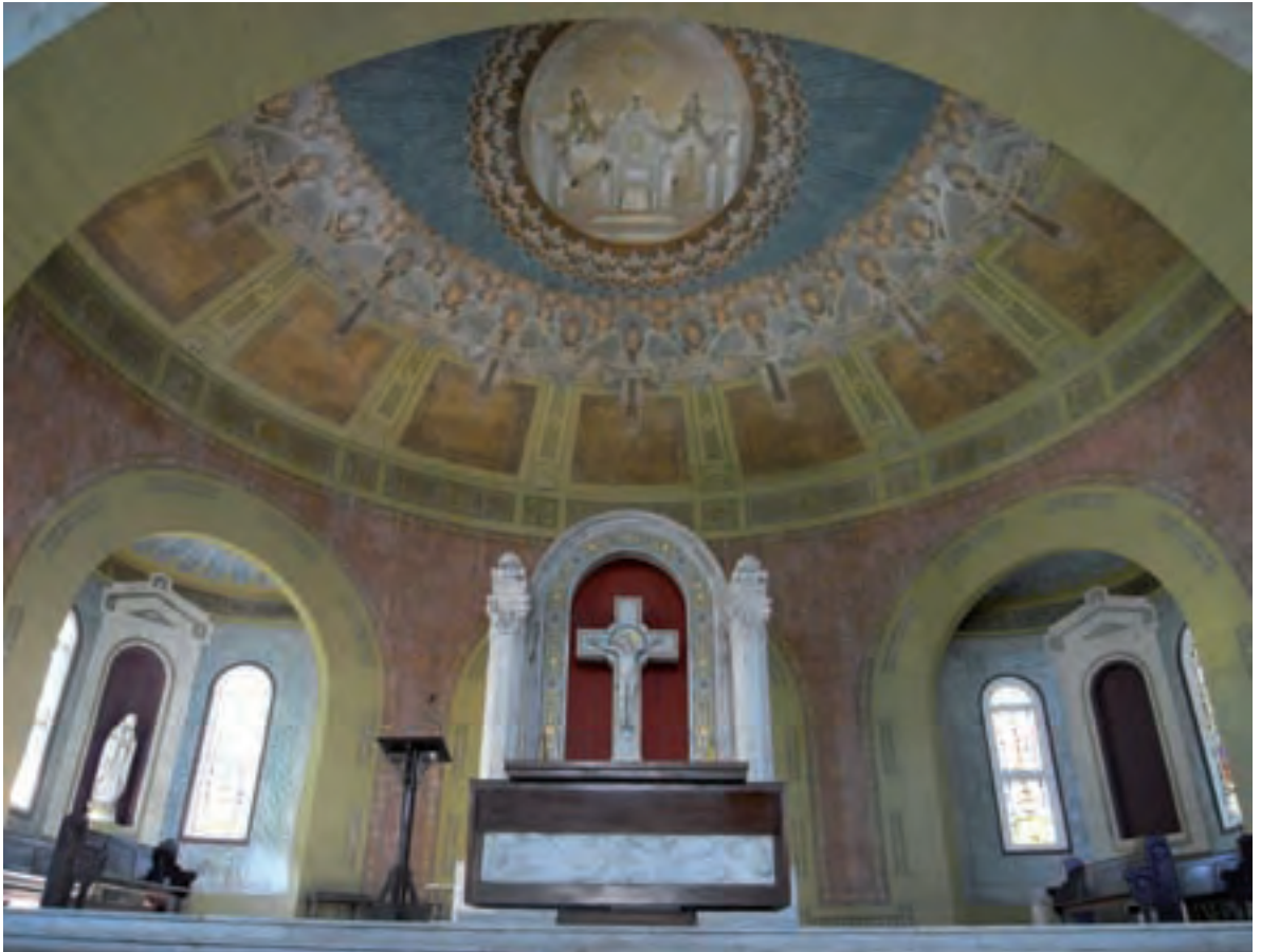
Arriba, Vista general del ábside después de la intervención.
