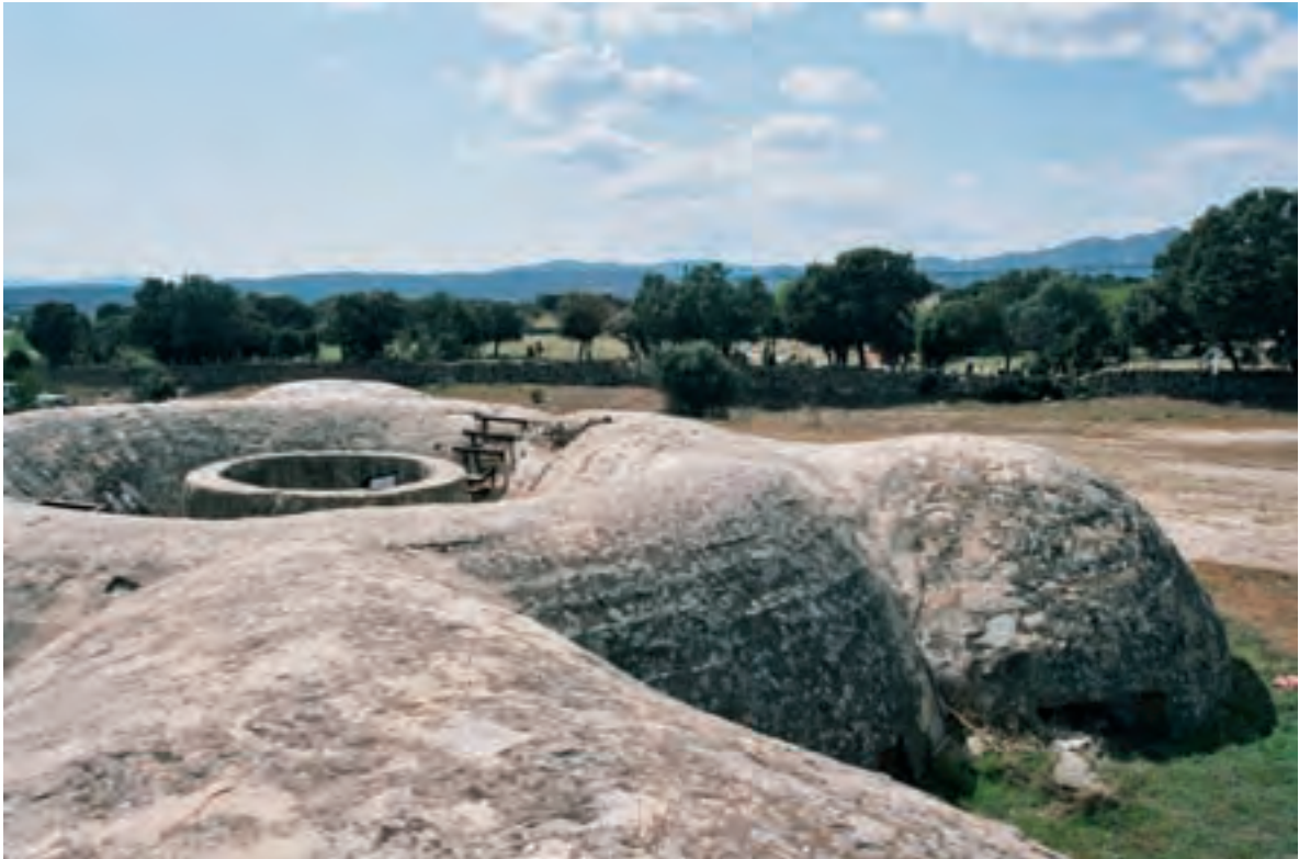
Arriba, Block Haus de Colmenar de Arroyo. Fortificación de hormigón armado del flanco izquierdo del sector franquista de Brunete, noviembre 1938 – enero 1939. Fotografía: Antonio Rodríguez Fernández.
