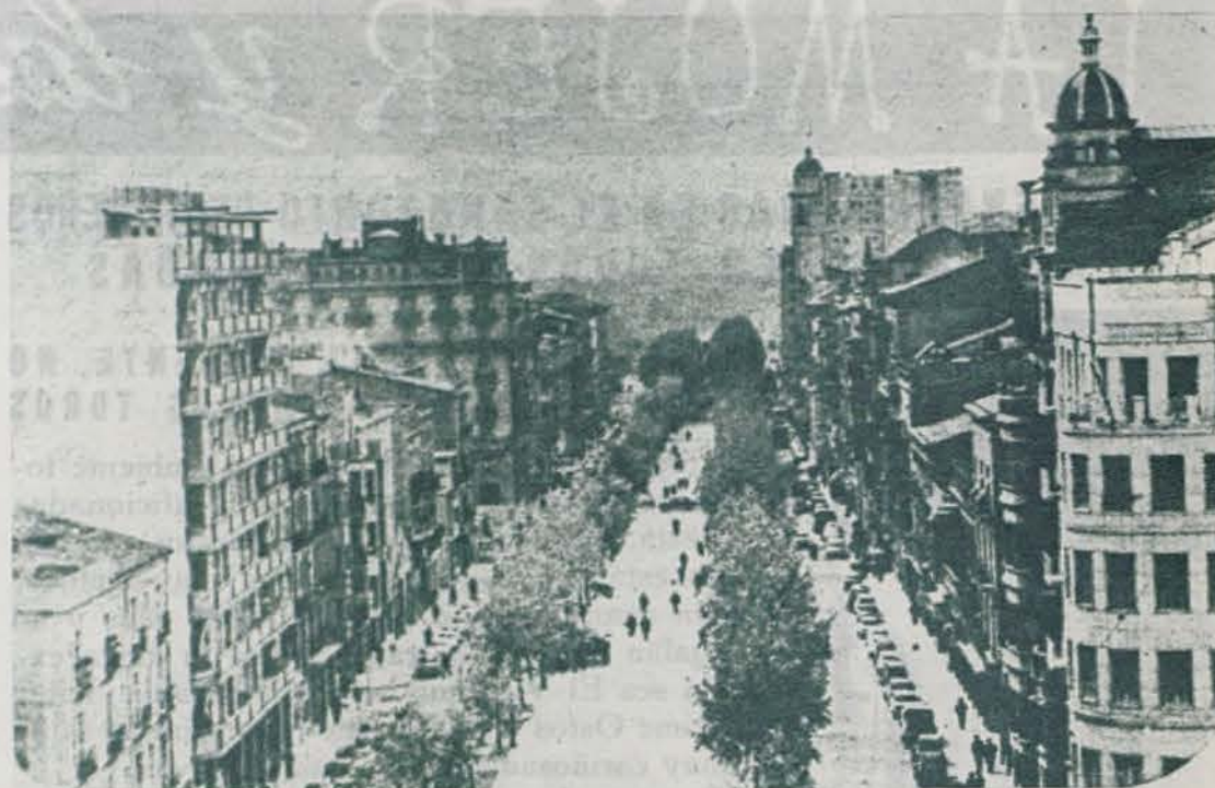
Una panorámica de la avenida del Caudillo, arteria principal de la bella capital leridana.
