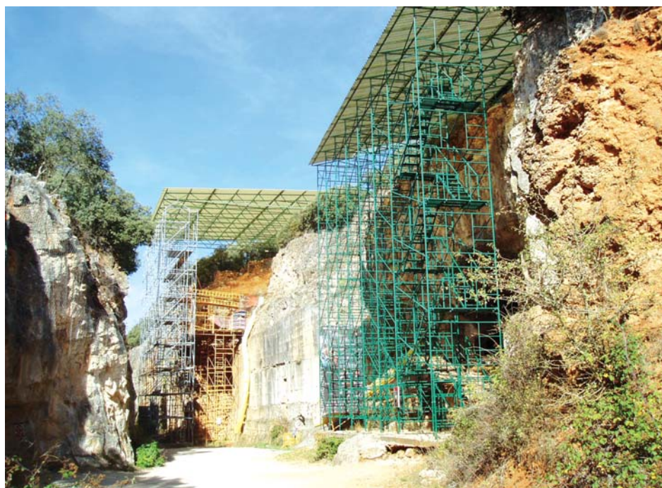
Trinchera del Ferrocarril
