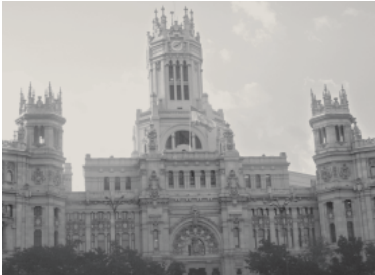
Palacio de Comunicaciones. Madrid.
