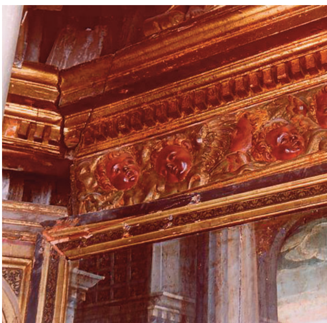
Fig. 7 Marco del Retablo Mayor de la iglesia de la Asunción de Nuestra Señora, Colmenar Viejo, Madrid. Roturas, pérdidas y daños ocasionados por el desmontaje de las tablas con ocasión de una exposición. Foto IPCE.
