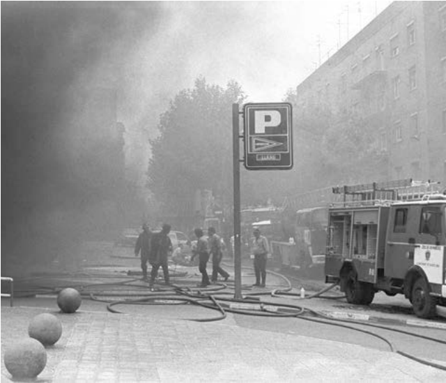
Bomberos intentan acceder al interior del aparcamiento del centro comercial Hipercor tras el atentado de ETA (Barcelona, 19/06/1987). Fotografía: agencia Efe.
