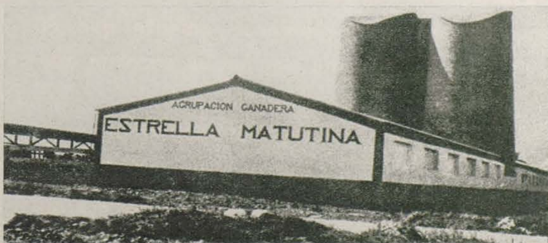
Aspecto de las instalaciones de una agrupación ganadera en tierras de Salamanca.
