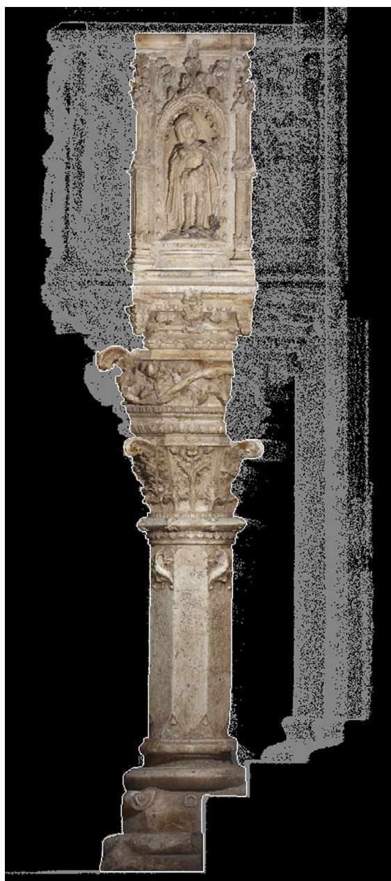
Figura 22. Ortofoto y nube seccionada de alzado del púlpito derecho de la Catedral de Sigüenza. Imagen: J. M. Lodeiro y Javier Laguna, Gabinete de Fotogrametría del IPCE.
