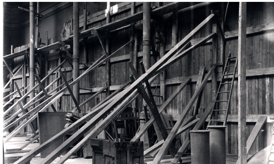
Fig. 64. Instalación de las estructuras de madera para la protección de yeserías y arcos en el Patio Árabe durante la Guerra (fot. MAN, FD00022 –reproducción del original del IPCE AJ-0004– y FD00026).
