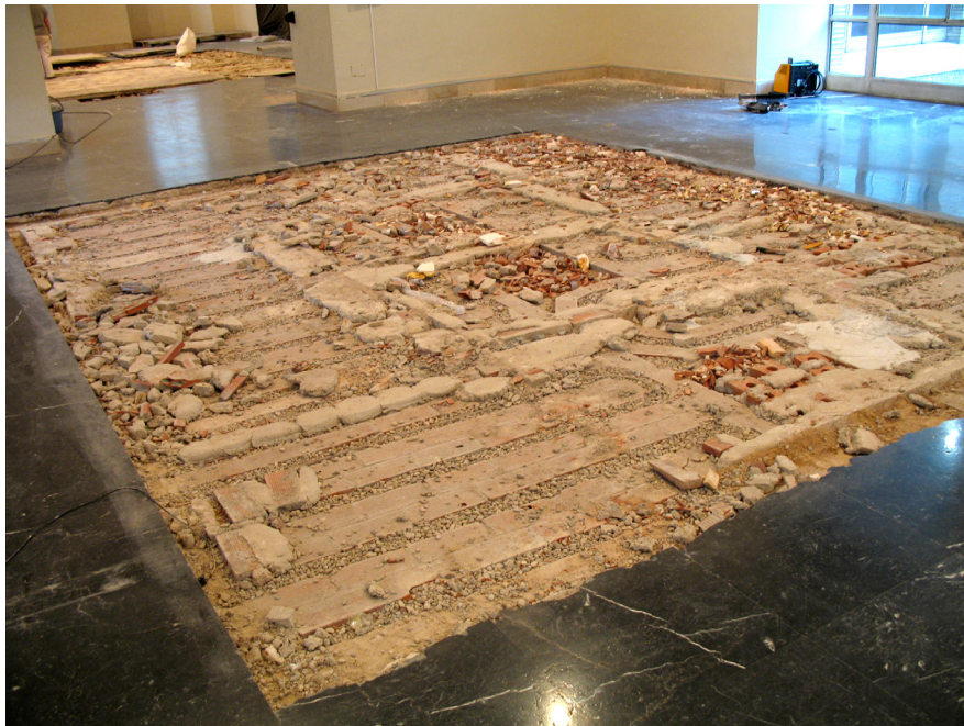
Fig. 21. Huellas de las instalaciones de la calefacción radiante bajo uno de los mosaicos de las salas tras su desmontaje para la última remodelación (fot. C. Dávila).
