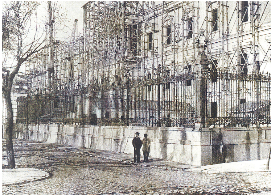
Fig. 2. Estado de las obras en 1891. Fotografía de Nicolás Caldevilla publicada en La Ilustración Española y Americana (en Marcos, 1993b: 117).
