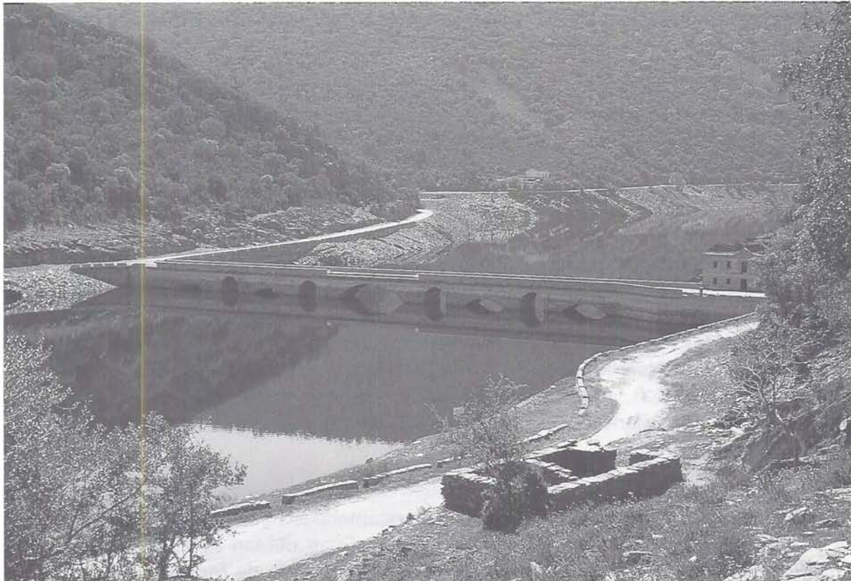
Restos de chozos y puente del Cardenal.
