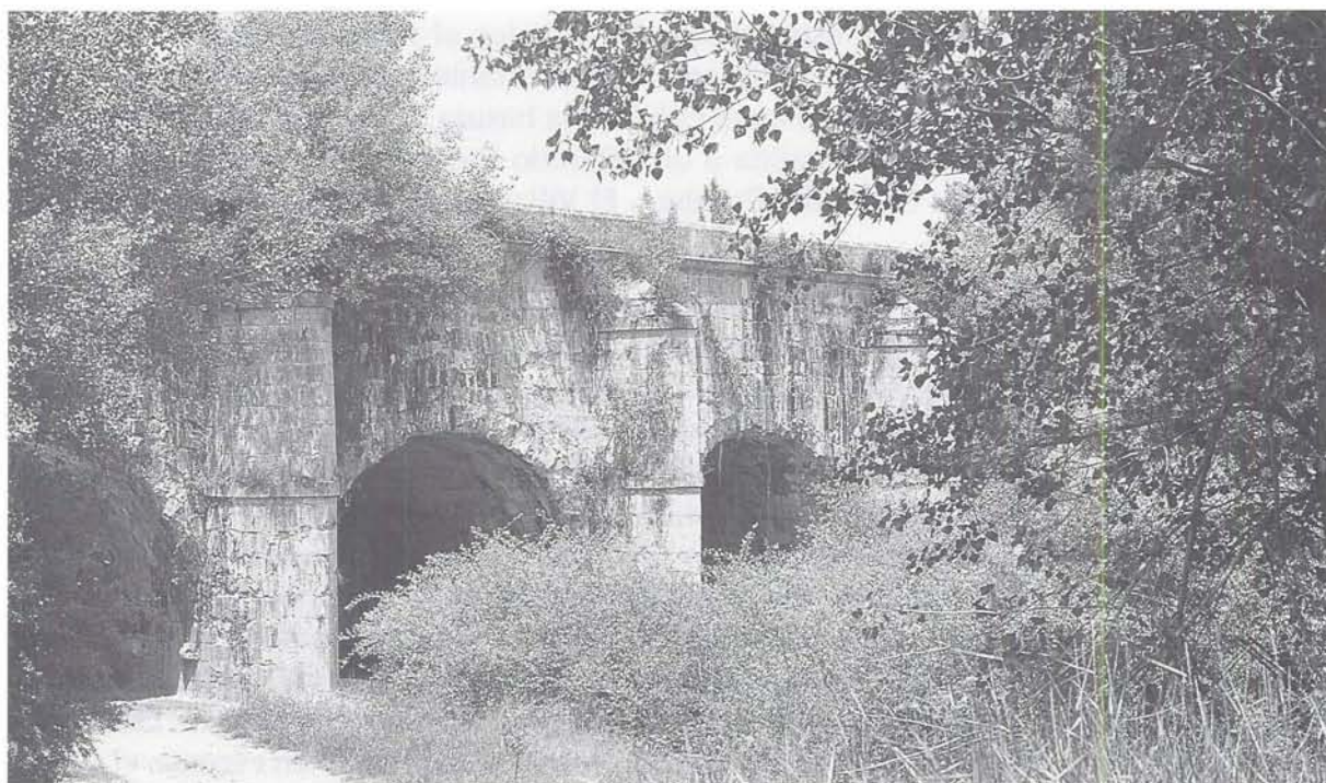
Acueducto de Abanades.
