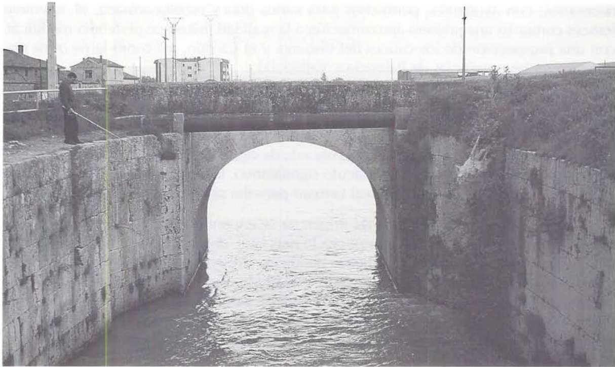
Puente sobre el Canal de Castilla.
