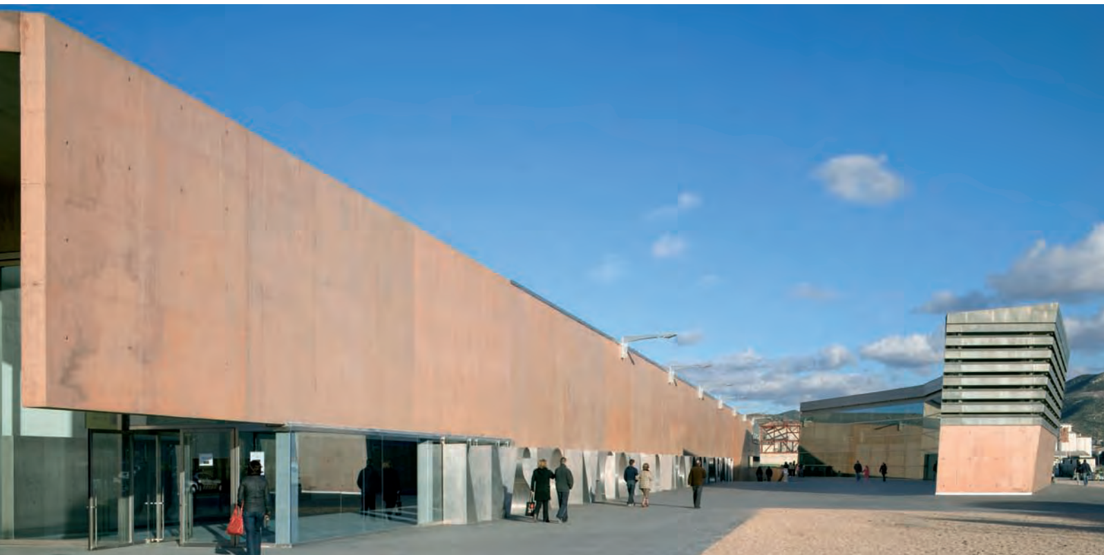
8. Vestíbulo abierto del museo. A la izquierda acceso a exposiciones temporales. © Duccio Malagamba.
