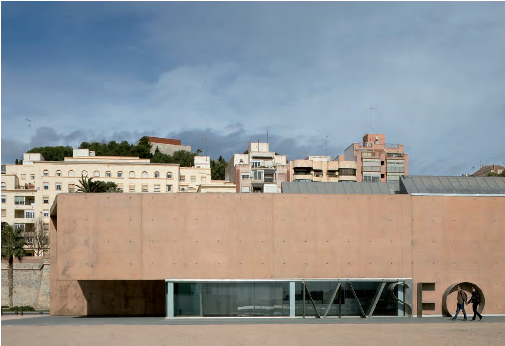
5. Extremo Este del edificio. Acceso a exposiciones temporales. © Duccio Malagamba.
