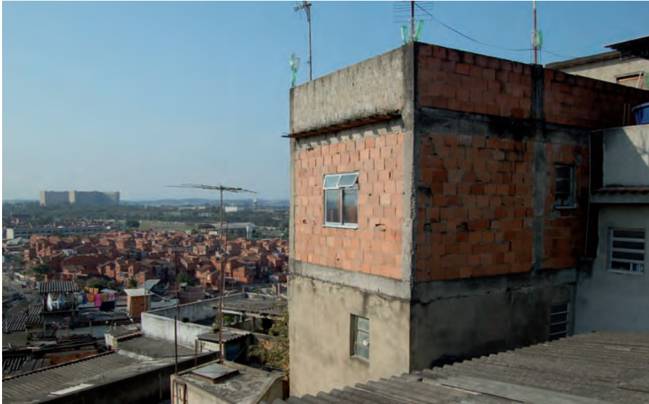
2. Vistas desde el CEASM. Al fondo, parte del Campus de la UFRJ (Universidad Federal de Río de Janeiro) situada en la Ilha do Fundao. Foto: Jorge Campana.
