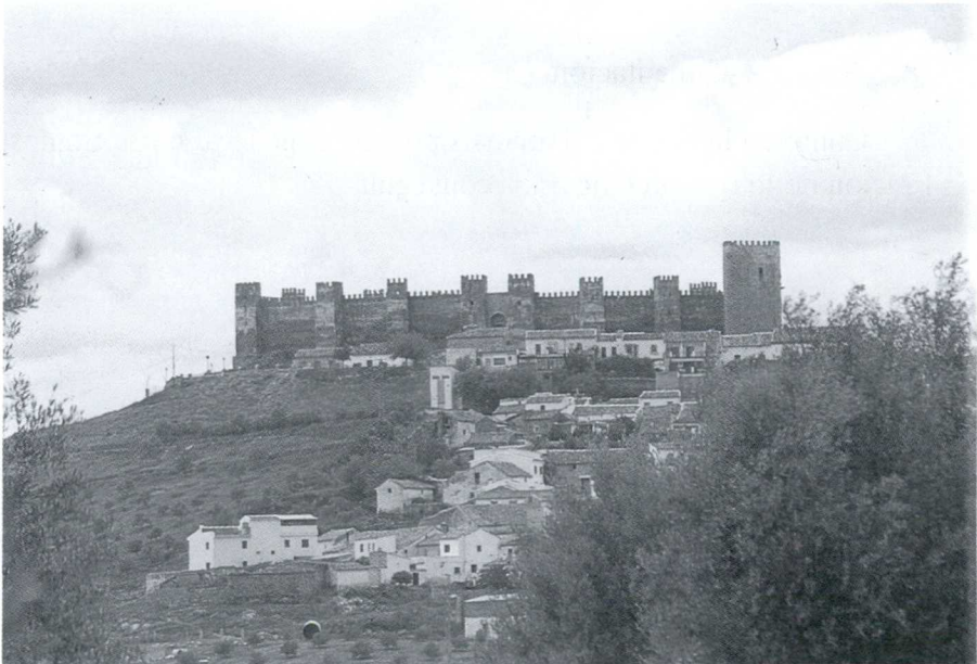
Baños de la Encina. El castillo se conserva externamente completo, por lo que pueden estudiarse sus torres, cortinas y puertas. En él se emplea la "tabiya" islámica, la mampostería cristiana y la sillería.
