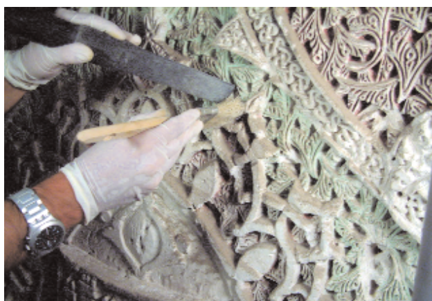
Figura 3: Proceso de restauración de las yeserías (Fot.: Archivo Fotográfico M. Sefardi)
