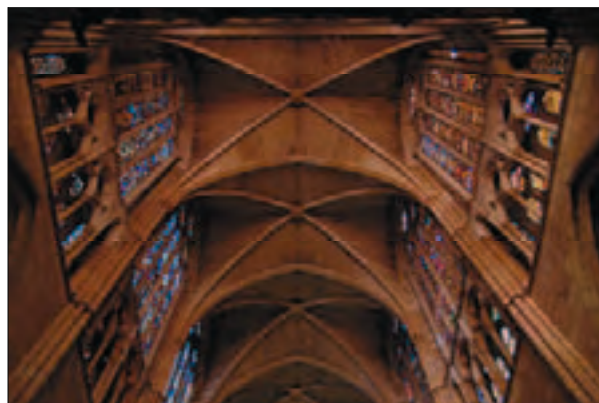
Bóvedas y nervaduras de la Catedral de León
