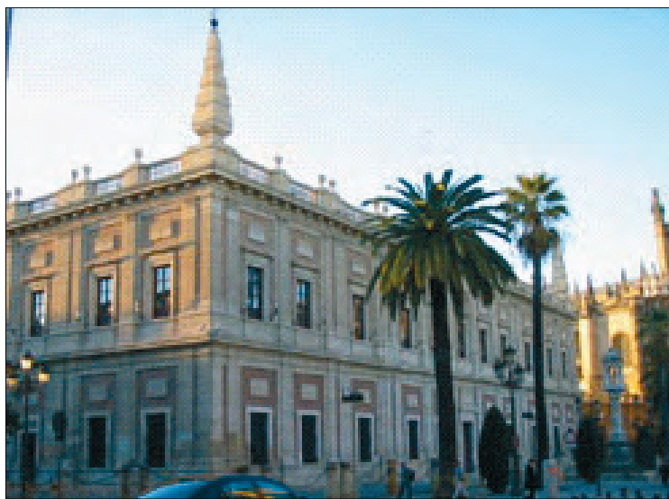
Casa de Contratación, actual Archivo de Indias, Sevilla
