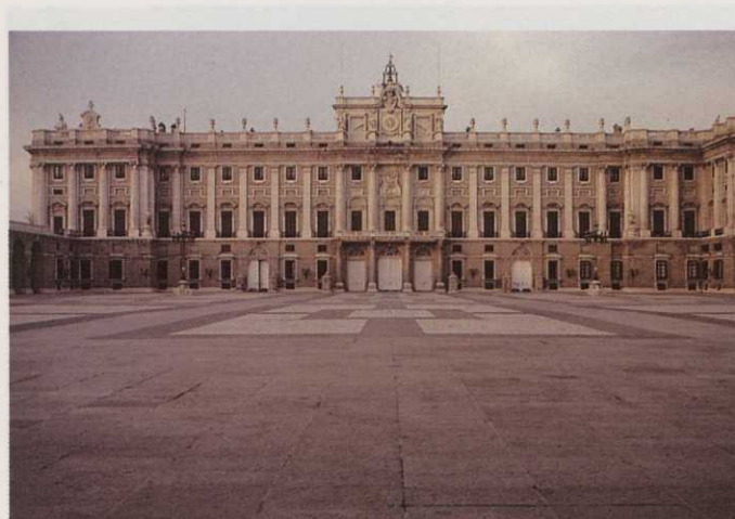
Figura 121 Inclinando la cámara hacia abajo se obtuvo un resultado mejor.
