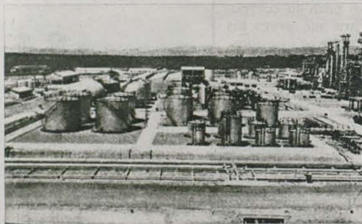
Una vista de la gran factoría "I. Q. A.", de Tarragona, inaugurada por el Jefe del Estado.
