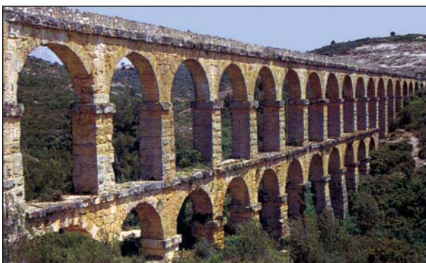
• Acueducto de Les Ferreres
