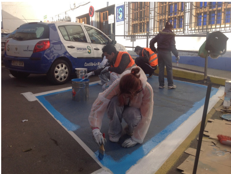
Realizando tareas de pintura de las zonas de aparcamiento para discapacitados.
