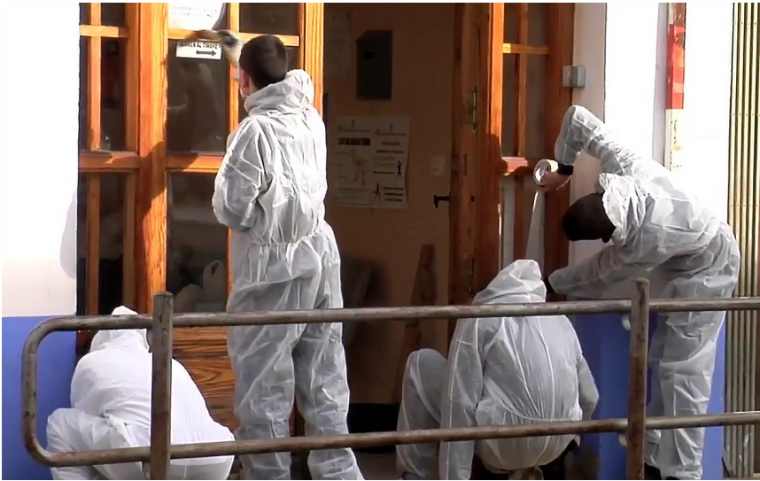
Realizando acondicionamiento de puertas de espacios públicos y su barnizado.
