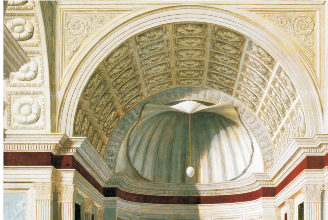
Figura 15. Detalle del ábside.
