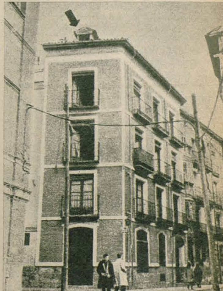
La casa de la calle de Leopoldo Cano, de Valladolid. La flecha señala la buhardilla en que pereció asfixiado el pequeño Isidoro.
