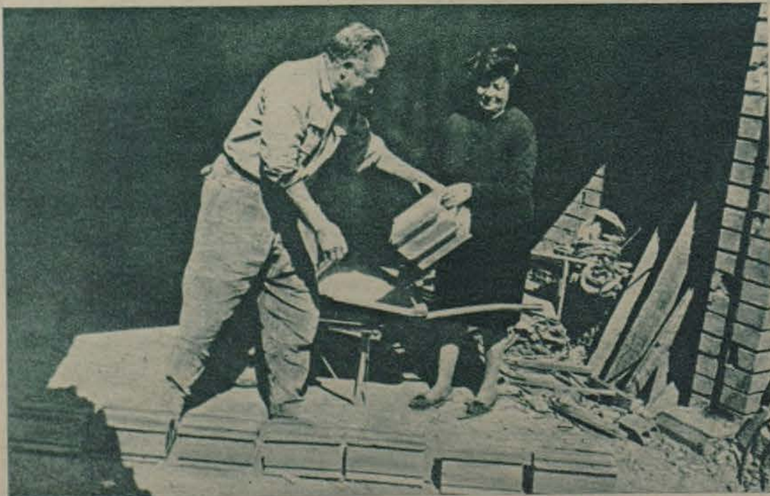
Ladrillo a ladrillo, puestos por sus propias manos, este esforzado matrimonio catalán se construye su propia casa. Los Gulu, vecinos de Hospitalet, llevan ocho años trabajando en la obra del edificio, que tendrá cinco pisos y es el gran sueño de su vida, casi hecho ya realidad.
