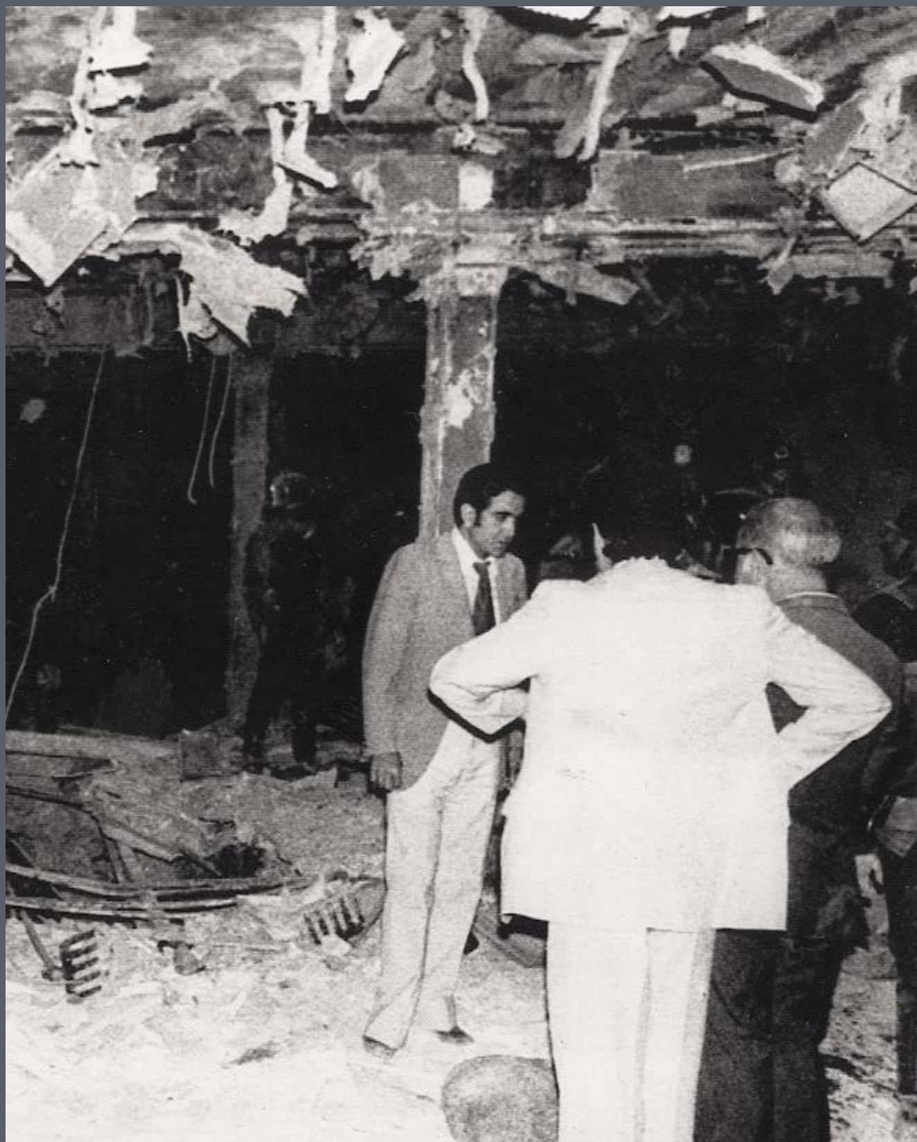
Fig. 6. Estat en què va quedar l'interior de la cafeteria Rolando després que hi esclatés una bomba d'ETA. Madrid, setembre de 1974. Fotografia: AMB, Fons de La Gaceta del Norte.
