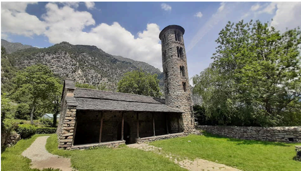
Puente de la Margineda e Iglesia de Santa Coloma, única con planta circular en el Principado y parte del patrimonio arquitectónico del país. Autor: Humberto Burcet
