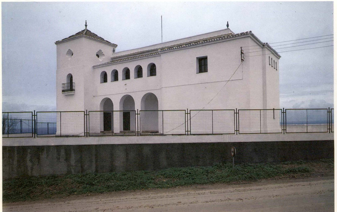
VILLALVA DE ALCOR (HUELVA). Preescolar, 160 puestos. Adaptación.
