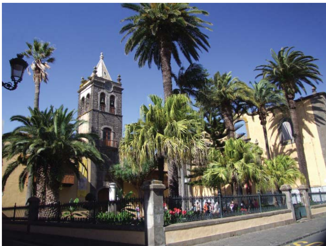
Foto 1. Fachada principal del Instituto. Fotografía: Ángel Cabaleiro.
