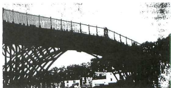
Puente de hierro colado construido por Darby sobre el río Severn cerca de Coalbrookdale en Shropshire; esta imponente construcción de hierro está sobredimensionada.
