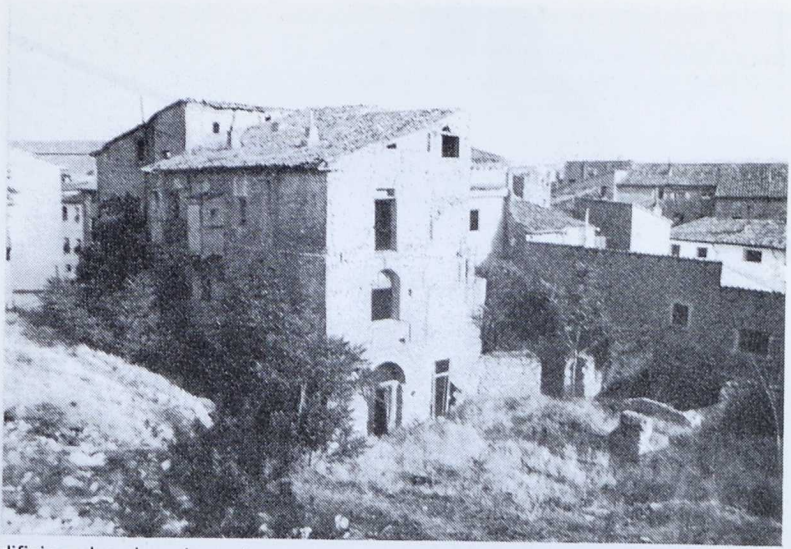
Edificios abandonados y basura en los solares próximos a la Cuesta de Santa Ana.
