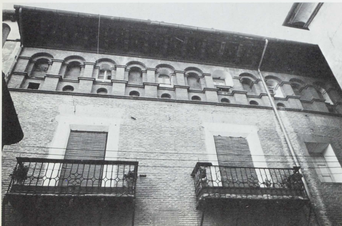
Edificio en calle de Gotor
