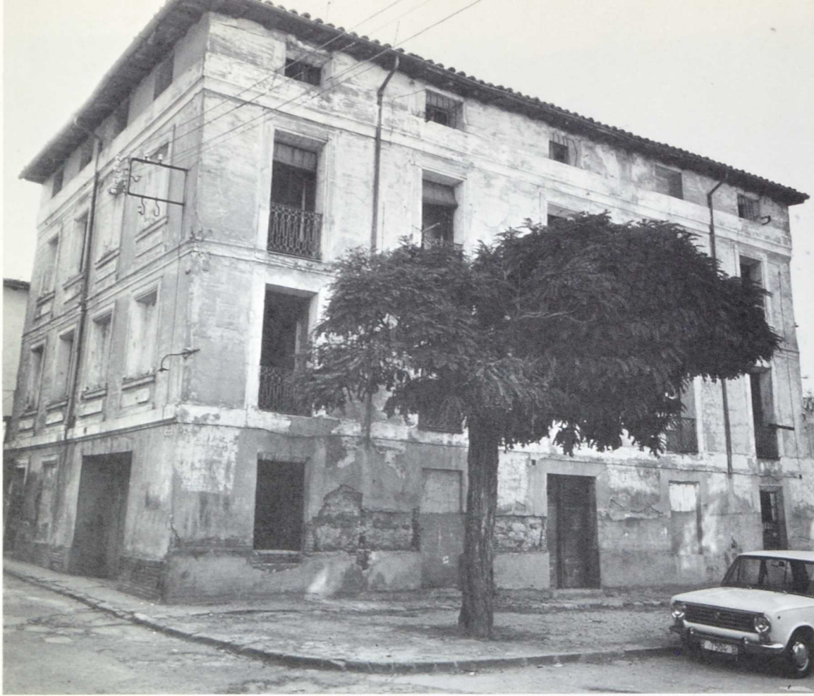
Edificio Plaza de Madrid
