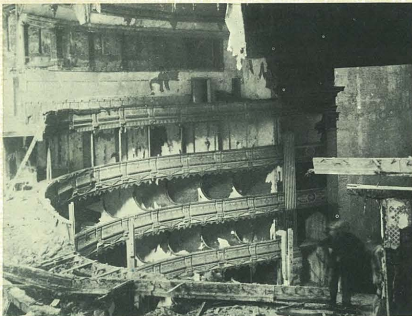
Estado del Teatro antes de las obras de restauración.
