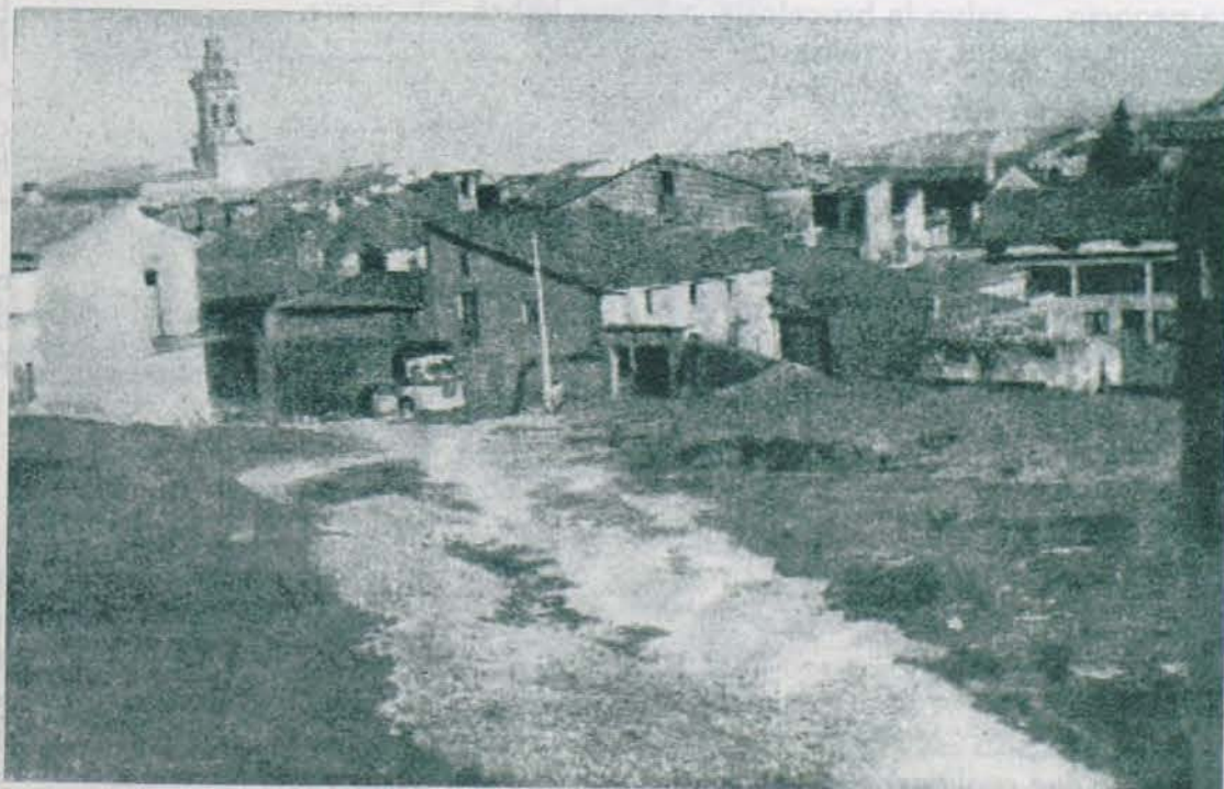
En estos terrenos se construirá el nuevo grupo escolar.
