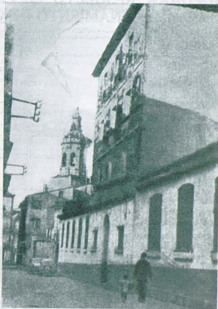
Edificio de las escuelas viejas.
