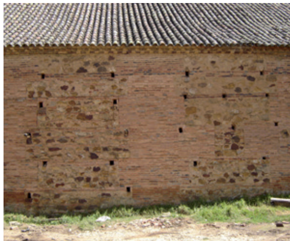
Figura 7. Muros maestros de la iglesia de Chivatá. Foto: A. Chica S., 2010.
