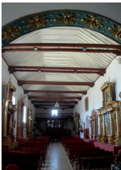
Figura 22. Cubierta en par y nudillo de la iglesia de Oicatá. Foto: A. Chica S., 2009.
