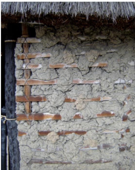
Figura 1. Bahareque entramado de madera embutido de barro. Foto: A. Chica S., 2012.
