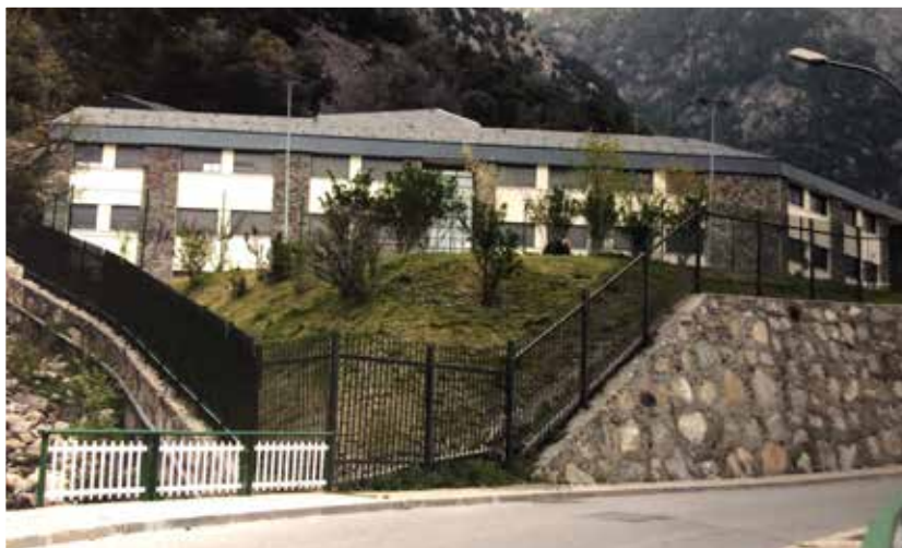
Instalaciones recién estrenadas del Instituto Español en La Margineda.
