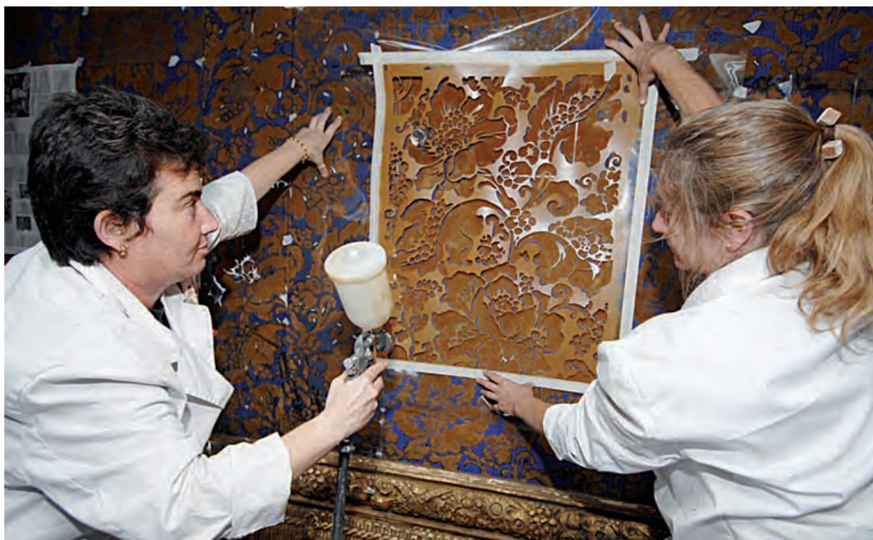
Arriba, proceso de consolidación del papel mural “in situ”, utilizando plantilla y aerógrafo.
