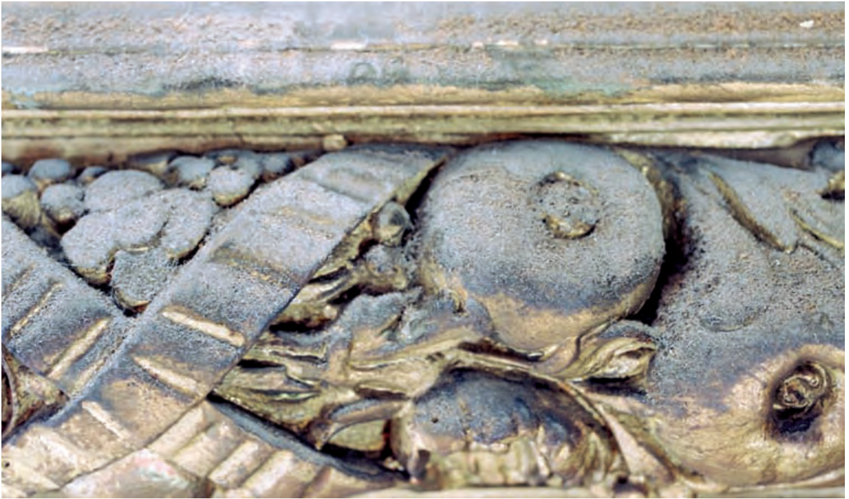
Arriba, estado de conservación de las molduras de yeso dorado, con gran acumulación de contaminantes ambientales, pérdidas de materia y oxidación de los pigmentos. Fotografía: Sergio Bolaños.
