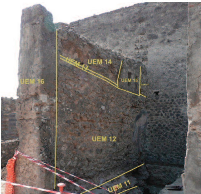
Fig. 9 Vista occidental del paramento este de la taberna 25 del macellum.
