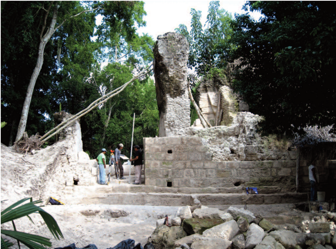
Fig. 9 Vista del cuarto 5 del Palacio de Oriente una vez concluida su excavación. (Fotografía Gaspar Muñoz).
