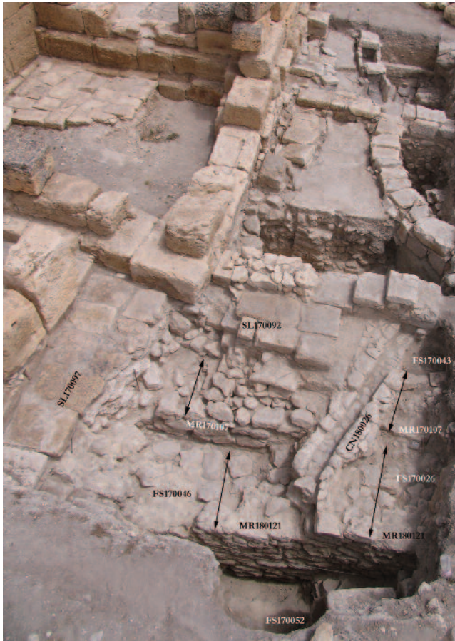
Fig. 12 Vista desde el sur de la zona al sur del capitolio, con la muralla númera (MR180121 y MR170107) en primer plano, y el conjunto de estructuras de fases posteriores que se adosan o superponen a la misma.
