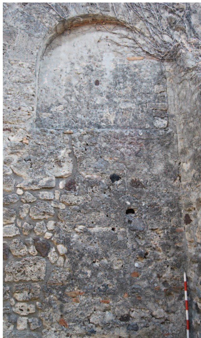
Fig. 11 Casa "di Arianna". Arco cegado del ambiente 22 desde el exterior.
