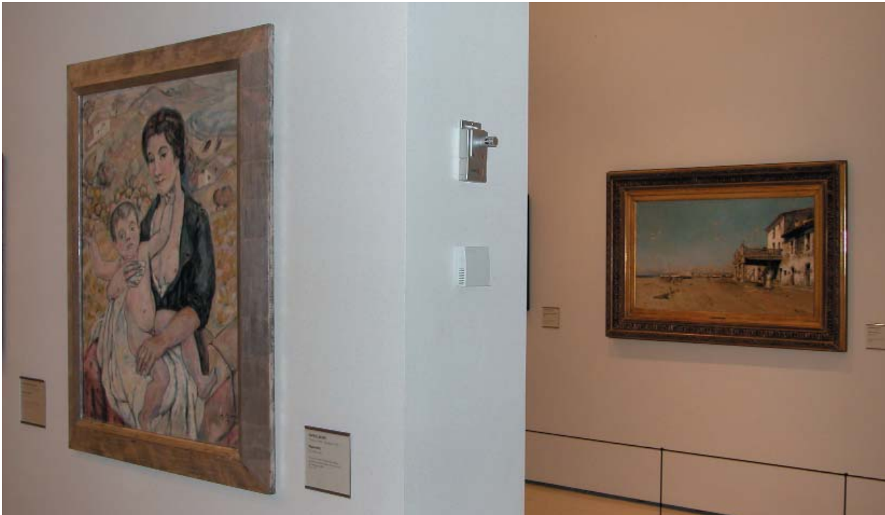
5. Comprobación de funcionamiento de la sonda de conservación preventiva (Foto: MNAC)
