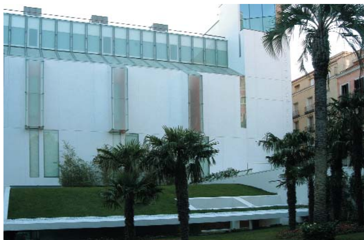
5. Museo Thyssen-Bornemisza. Fachada de la ampliación (Foto: Museo Thyssen-Bornemisza)
