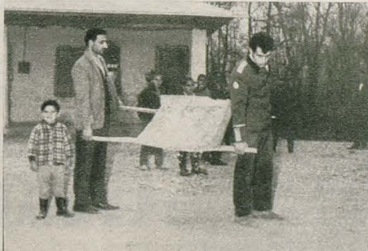
Maestro y alumno transportan materiales para la construcción de una escuela.
