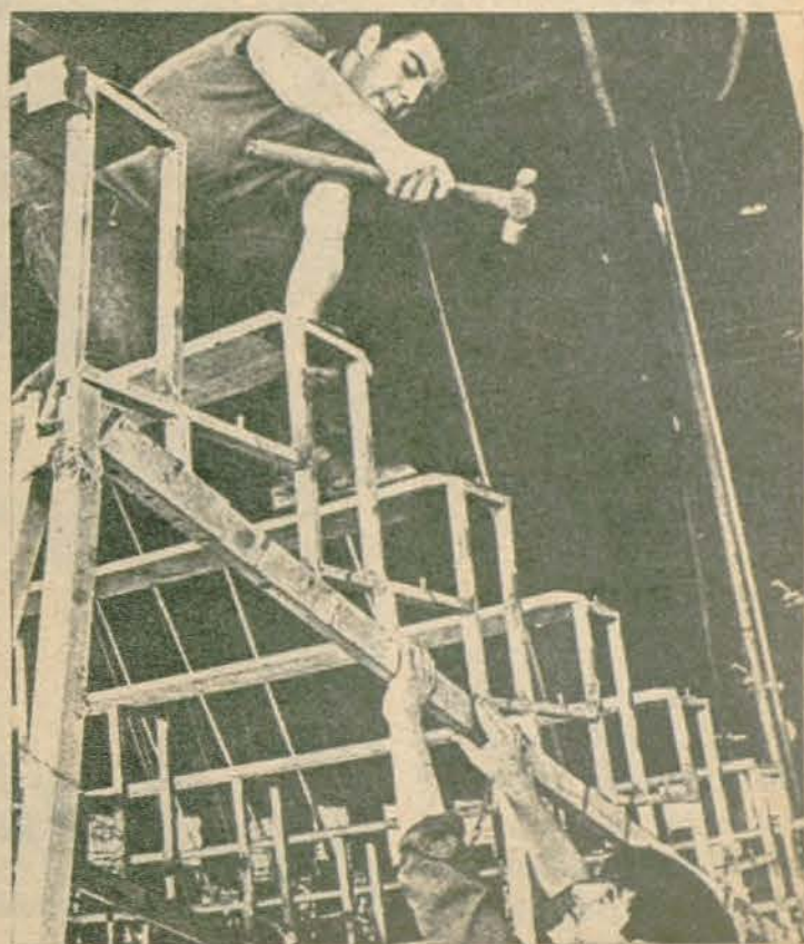
En plena faena de montaje del circo.
