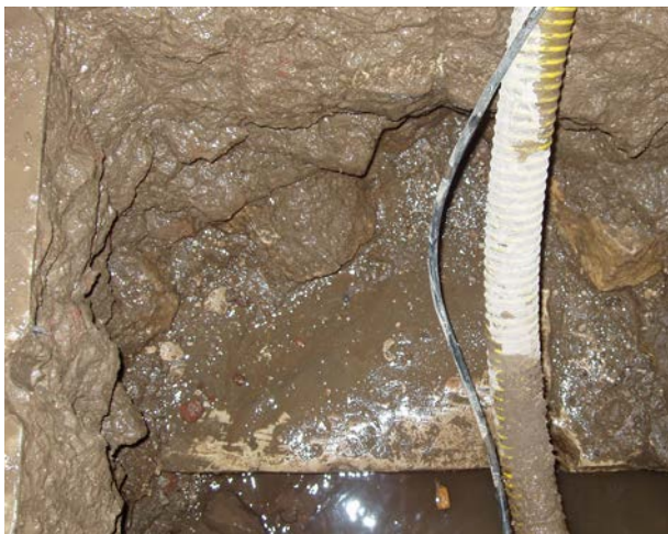
Fig. 7. Descubrimiento de los sillares de piedra de uno de los muros de contención del canal de Trajano bajo la cripta de la iglesia de Abu Sirga. Foto: Andrés Álvarez.
